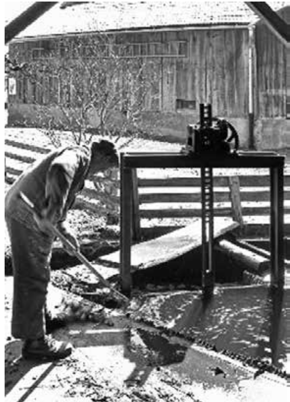
Abb. 4: Reinigung des Rechens
