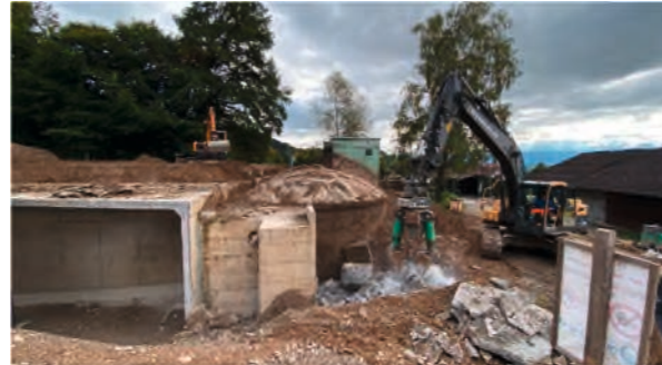
Rückbau des alten Reservoirs, links steht bereits das neue Reservoir
