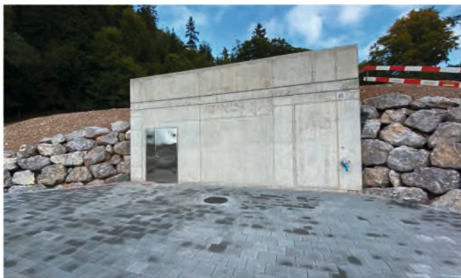
Aussenansicht des neuen Reservoirs
