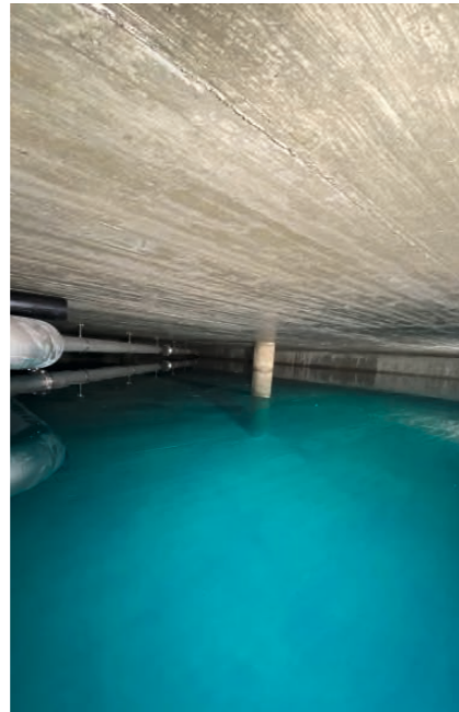
Blick in eine neue Reservoirkammer
